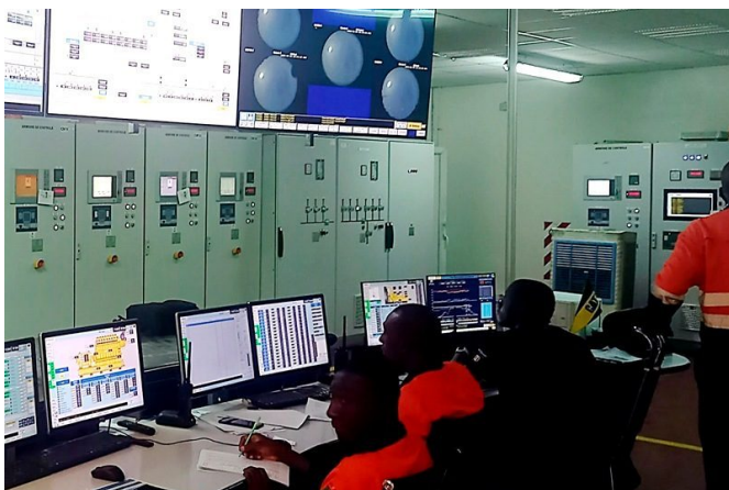
左图：Loulo 控制室，SCADA 系统图与 INSTANT 相机墙接入能量管理系统。右图：INSTANT 实时仪表盘，九台全天空成像仪、30 分钟预报、分相机 GHI 与云移动矢量。
